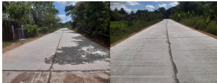
ดำเนินการก่อสร้างแล้วเสร็จ
