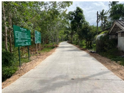
ดำเนินการก่อสร้างแล้วเสร็จ
