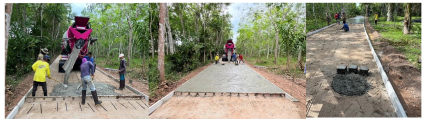
กำลังดำเนินการก่อสร้าง
