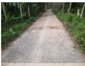
ก่อนดำเนินการก่อสร้าง
