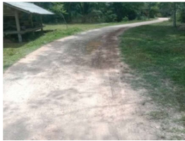
ก่อนดำเนินการก่อสร้าง
